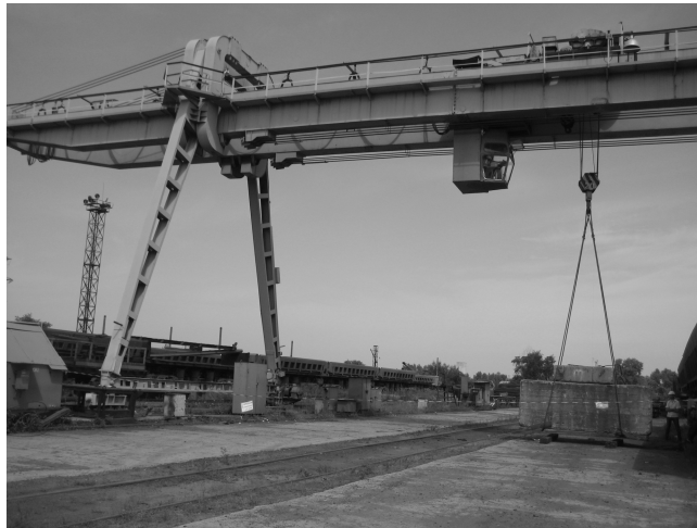
Рис. 2 – Канатные затяжки при усилении металлоконструкции козлового крана грузоподъёмностью 20/5 т, пролётом 32 м
